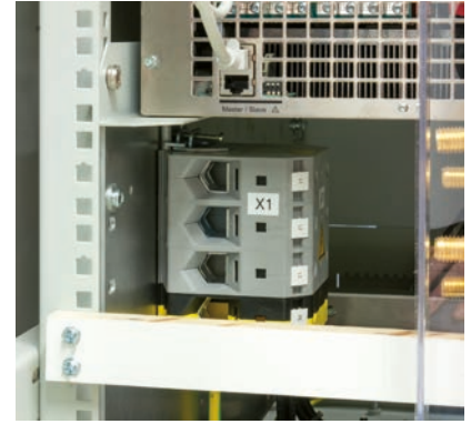
交流输入端 / AC input terminal
